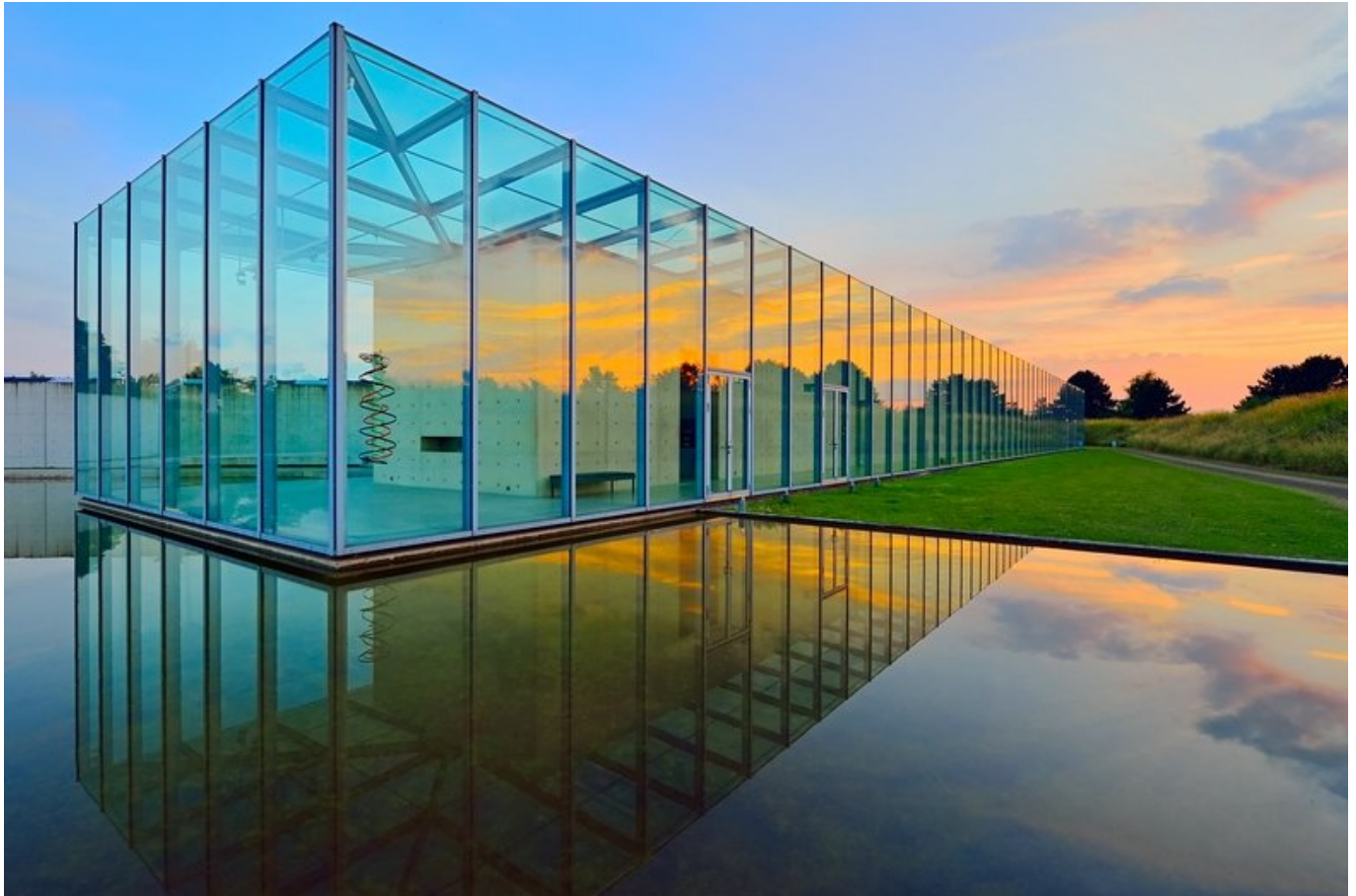
Tadao Ando | Ausstellungsgebäude Langen Foundation | Hombroich Deutschland | 2004 © Marcel Chassot
