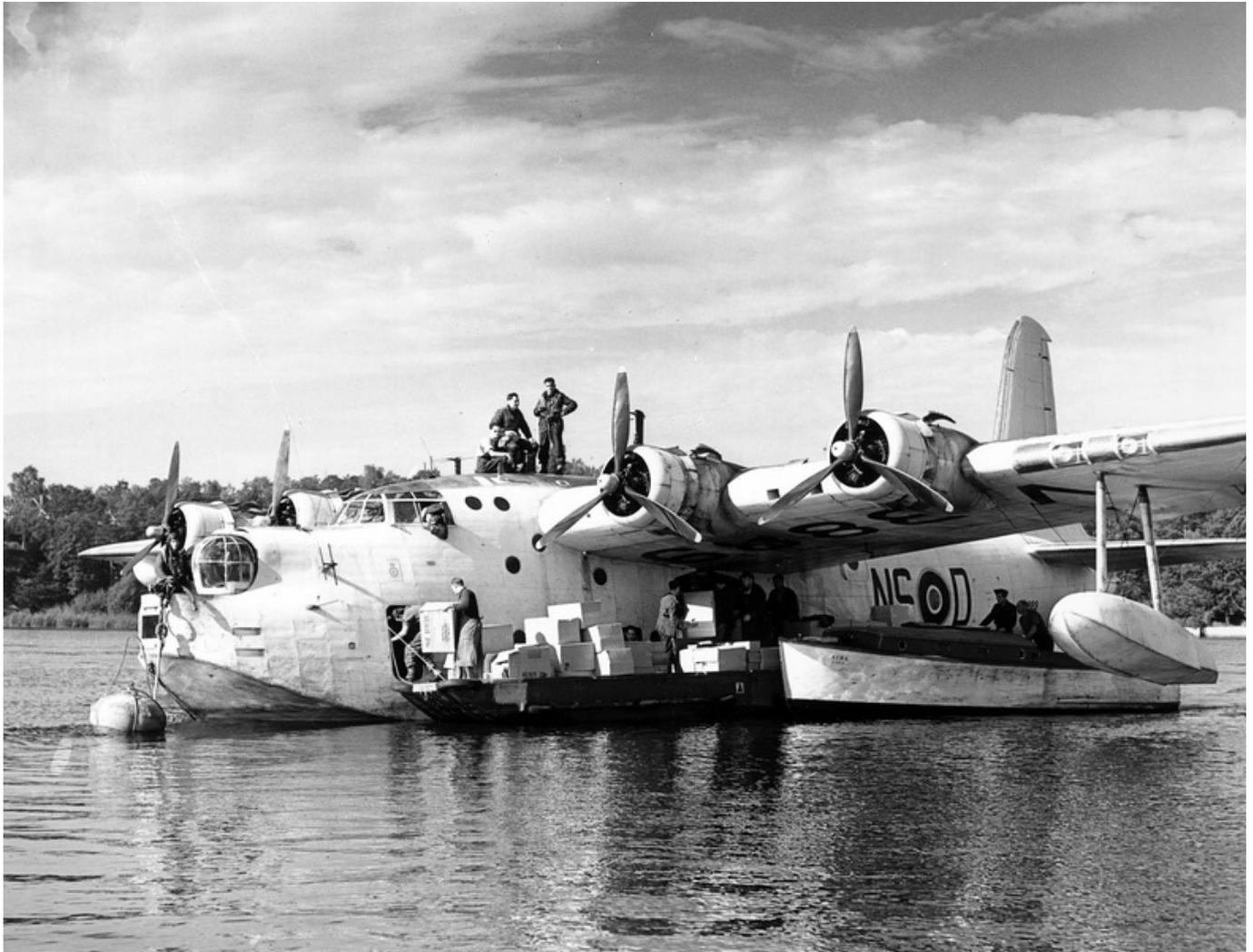
Die britischen Sunderland-Flugboote wurden im Zweiten Weltkrieg bei der Jagd auf deutsche U-Boote eingesetzt. Während der Luftbrücke transportierten sie häufig Salz, wofür die meisten anderen Flugzeugtypen aufgrund der Korrosionsgefahr nicht in Frage kamen. Die Boote starteten und landeten auf der Havel bei Schwanenwerder. Crown copyright 1948, reproduced under the terms of the Open Government Licence, published as a courtesy of Air Historical Branch, RAF (GAT R-1831)
